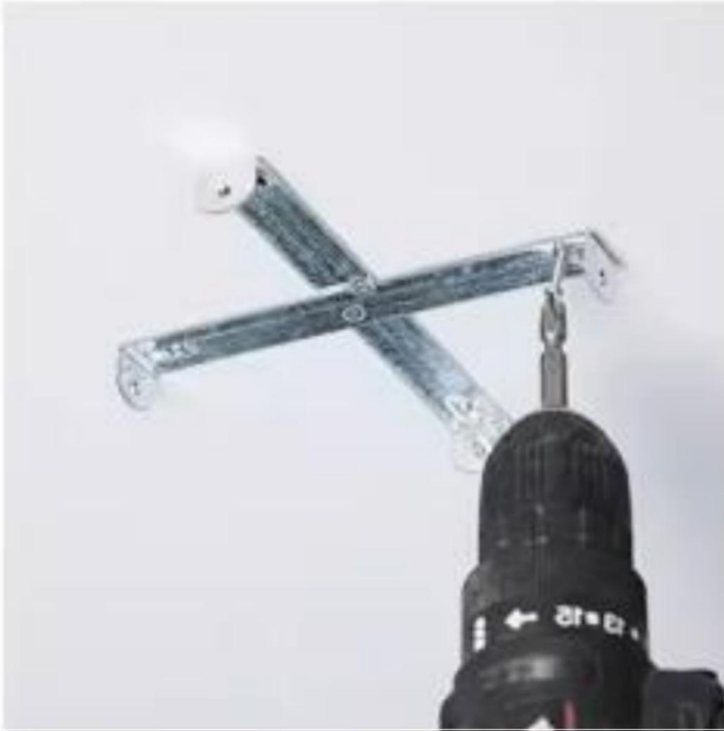
1. Bohren Sie Löcher in die Querstreben und montieren Sie sie auf dem Dach.
