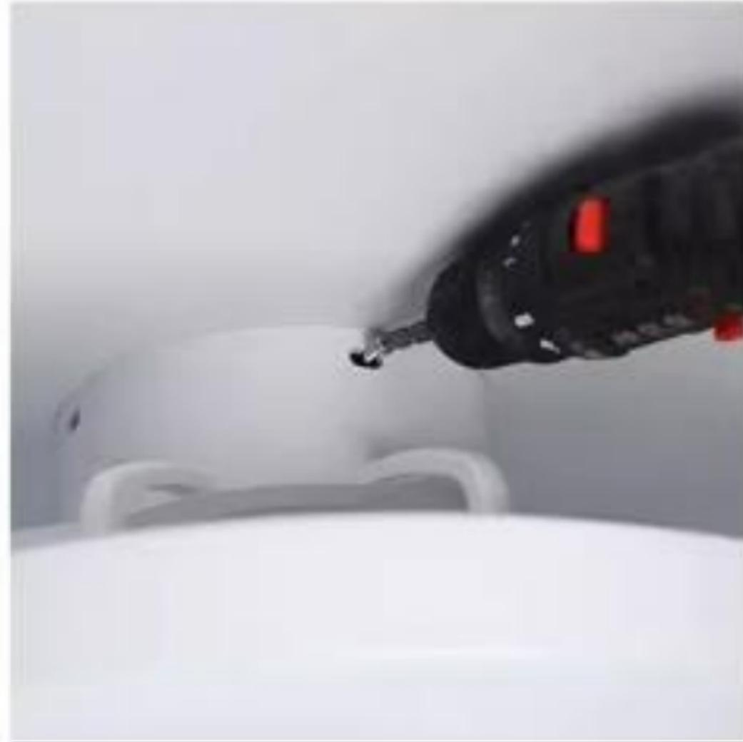
2. Fixieren Sie die Gebläseleuchte an der Querleiste und schalten Sie sie ein.
