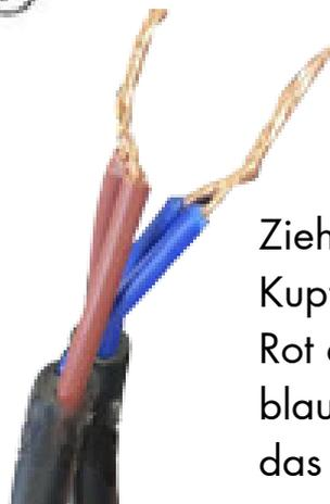
Ziehen Sie die 5 Kupferdrähte zusammen, Rot an Rot, Blau an blau, und schließen Sie das Netzkabel an.
